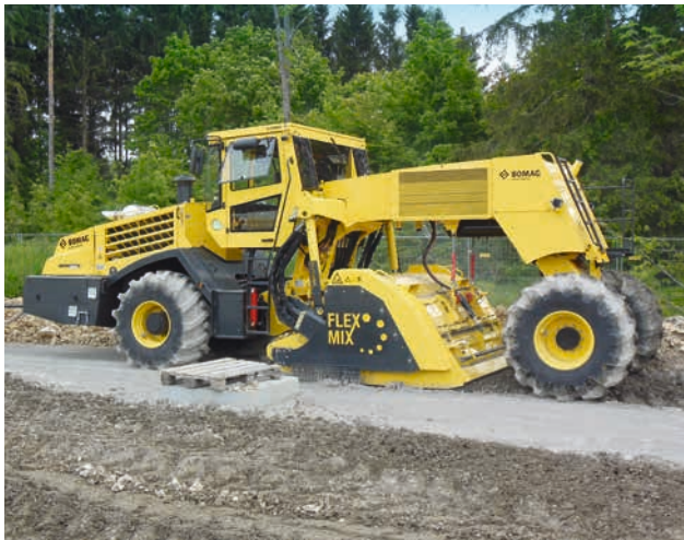
Lavorare a filo scavo a sinistra ...
