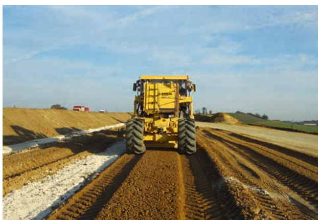
Miscelazione ottimale e strati di spessore omogeneo con la tecnologia BOMAG FLEXMIX.
