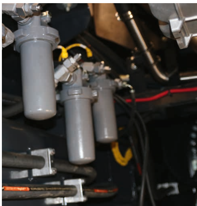
Sistema di filtraggio idraulico.
