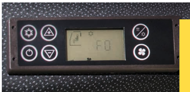
Pannello di controllo dell'impianto automatico di riscaldamento e di climatizzazione.
