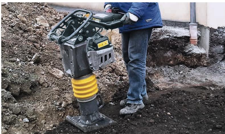
\*I vibrocompattatori BOMAG con motori a benzina Honda GXR-120 (BT 60 e BT 65) possono essere utilizzati anche in scavi più profondi dell'altezza delle spalle e una larghezza minima di 1,5 m. Maggiori informazioni sono disponibili all'indirizzo: [www.bgbau.de](http://www.bgbau.de) (BG Bau, Germania, 2015).
