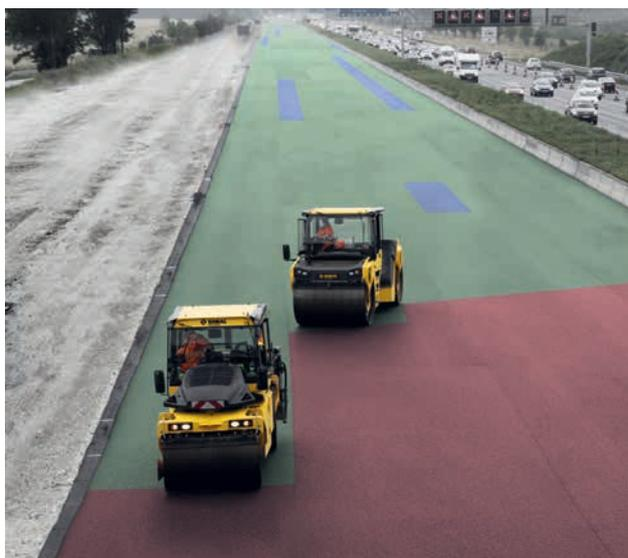
Le tecnologie e i sistemi di assistenza BOMAG rendono trasparente il risultato della compattazione.
