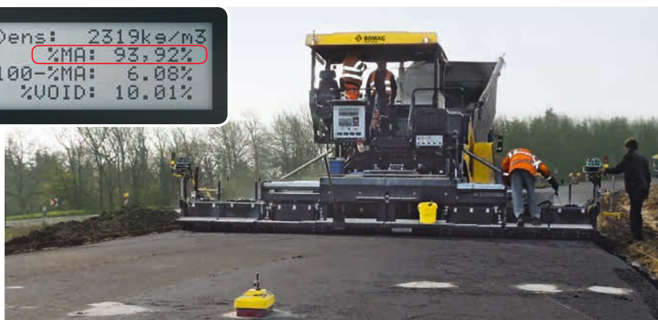
Strato di binder AC 16 BS di 4 cm su una larghezza di 8,0 m; precompattazione misurata in densità Marshall 93,92%.
