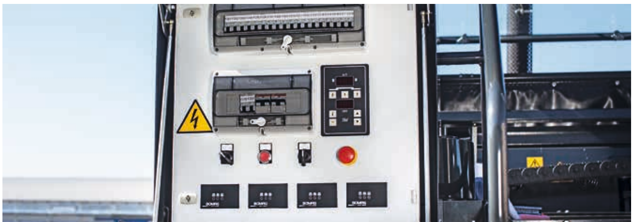
Pannello di comando con monitoraggio del riscaldamento.
