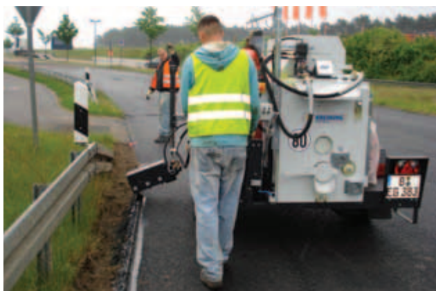
Hot bitumen slurry
