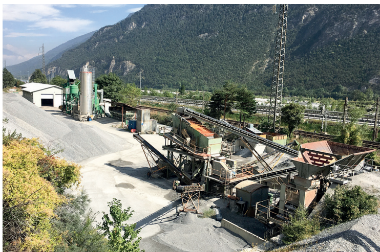
L'impianto di frantumazione e di produzione di conglomerati bituminosi di Edilstrade
