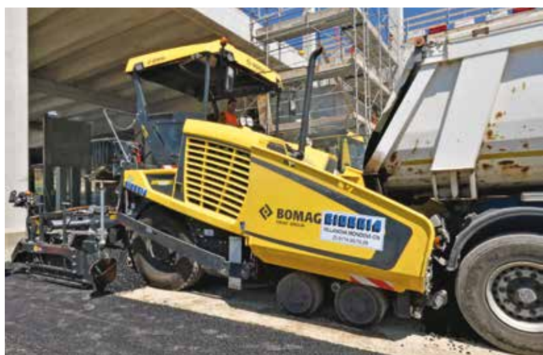
1. La nuova Bomag BF 600 all'opera nel nuovo stabilimento della Fiorentini Alimentari di Trofarello (TO) per la pavimentazione degli spazi esterni di transito, di sosta e di manovra e i parcheggi aziendali
