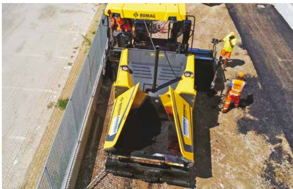
9. Il sistema Sideview si è rivelato particolarmente utile in un contesto come questo in cui ostacoli di ogni tipo vanno attentamente considerati in fase di stesa del conglomerato
